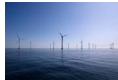
Điện quạt gió
